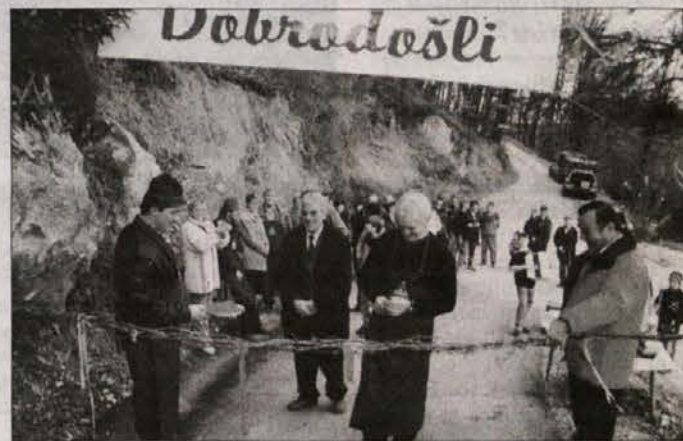
DEBENEC DOBIL SE 423 M ASFALTA – Predsednik gradbenega odbora za posodobitev odseka ceste proti vrhu Debenca Dušan Bevc je otvoril asfaltirano cesto, pri svečanem otvoritvi pa sta mu pomagala še trebanjski župan Ciril Pungartnik in predsednik KS Mirna Janez Bracko. Ta je izdatno podprla 4,3 milijona tolarjev vredno naložbo, vinogradniki oz. domačini pa so prispevali okrog 1,2 milijona tolarjev in svoje delo. Strmi odsek ceste je zdaj tudi z muldami zaščiten pred vodo ob neurjih, ki je odnašalo makadam v dolino. (Foto: P. P.)
