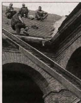
OBNOVA STREHE - Prejšnji teden so prekrili z novo strešno opeko streho nekdanje samostanske cerkve v Kostanjevici, prvotnega stavbnega spomenika zgodnje gotike pri nas, v katerem Galerija Božidarja Jakca prireja odmevne likovne razstave, in s tem zaključili letošnji program obnove. (Foto: MiM)
