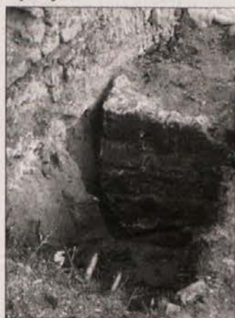
Ostanki gradnje iz rezanega kamna pod starim mestnim obzidjem.
