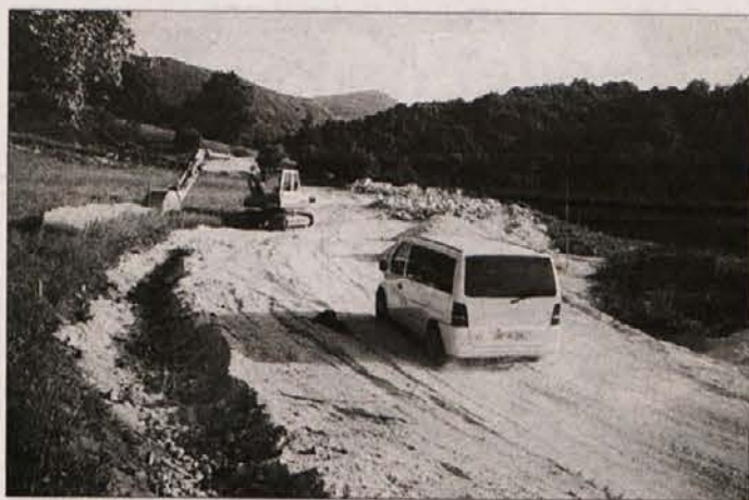
PODGORSKA MAGISTRALA – Vožnja po cesti z Dolža proti Pangrč Grmu se za sedaj konča tik pod Pangrč Grmom. Tam sedaj gradijo veliko kamnito zložbo na mestu, kjer se je sprožil zemeljski plaz. Letos naj bi pri gradnji te ceste opravili še zadnja zemeljska dela, prihodnje leto pa bodo vasi pod Gorjanci že povezane s prečno "podgorsko magistralo". (Foto: A. B.)
