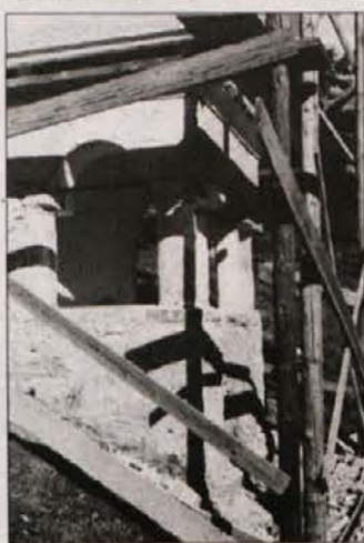
Obnova kapelice v Retjah.
