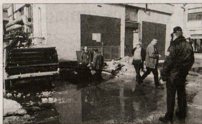
SPORNA DELA - Delavci Bgrada, ki so prejšnji četrtek opravljali dela ob nekdanji Pionirjevi kotlovnici v Bršljino, sta varovala dva varnostnika. Naslednji dan je inšpektor dela ustavil. (Foto: A. B.)
