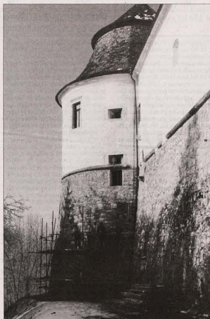
Stolp zahodnega trakta gradu nad strmim pobočjem, pod katerim je suha struga pobočja Krke in Save. (Foto: M. Markelj)
