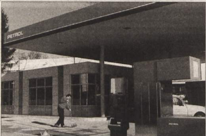
PRENOVILI BENCINSKI SERVIS - Prejšnji ponedeljek so v Sevnici odprli prenovljeni Petrolov bencinski servis, ki bo poslej ponujal več in bo imel tudi daljši delovni čas, hkrati pa bo bolj prijazen delavcem. Ti so zadnje dneve pred otvoritvijo imeli polne roke dela, pri čemer niso opravljali običajnih opravil, ampak so med drugim tudi krepko mahali z metlo (na fotografiji) in še s čim. (Foto: B. D. G.)
