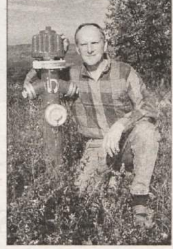
PRI HIDRANTU - Na zgrajeno vodovodno omrežje na daleč opozarjajo hidranti (na fotografiji je ob njem Janko Miketič iz Gorenjega Leskovca), žal si ljudje v primeru požara z njimi še ne morejo pomagati, ker v ceveh ni vode. (Foto: J. D.)
