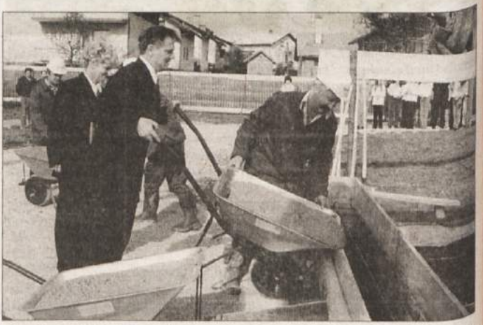
TEMELJNI KAMEN - Črnomaljska osnovna šola Loka bo dobila nov prizidek. Za gradnjo so pretekli teden na črnomaljski občinski upravi podpisali pogodbo z gradbenim podjetjem Begrad, potem pa sta ravnateljica Danica Pucelj in črnomaljski župan Andrej Fabjan slovesno položila temeljni kamen. Investicija je ocenjena na približno 170 milijonov tolarjev. Velikega pomena bo predvsem zato, ker izobraževalno delo na šoli zdaj poteka v sedmih različnih oblikah in v štirih lokacijah, med drugim tudi na več kot deset kilometrov oddaljenih podružničnih šolah v Adlešičih in Gribljah, kamor dnevno vozijo učence. (Foto: T. Jakš)
