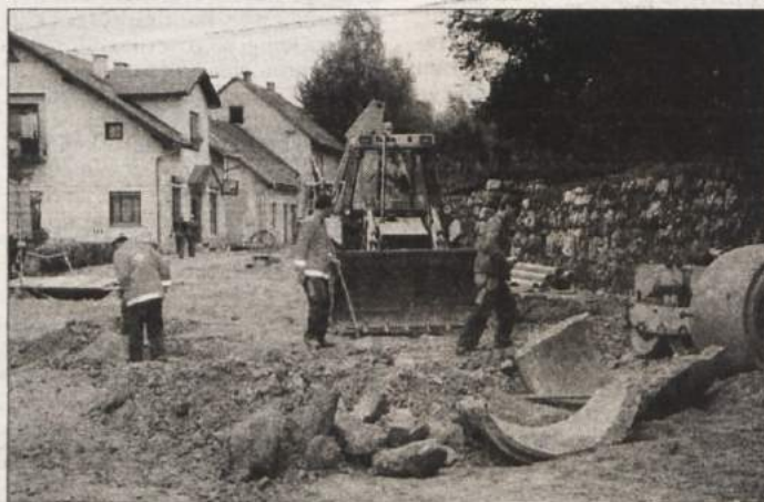
OBNOVA KOLODVORSKE CESTE - V Črnomlju naj bi do 20. novembra končali obnovo Kolodvorske ceste od "bele hiše" do hotela Lahinja. Sedaj polagajo cevi za elektroinstalacije za javno razsvetljavo, vodovod, kanalizacijo, za kar bo občina odštela 41 milijonov tolarjev. Iz državnega proračuna pa bo prišlo 60 milijonov tolarjev za gradbena dela, asfalt, semafor. V prihodnjem letu pa bodo nadaljevali še z drugim delom obnove hotela Lahinja po Belokranjski cesti do železniškega nadvoza. Tudi za ta dela je v državnem proračunu že zagotovljenih 60 milijonov tolarjev, medtem ko bo občinski prispevek 8 milijonov tolarjev. (Foto: M. B.-J.)
