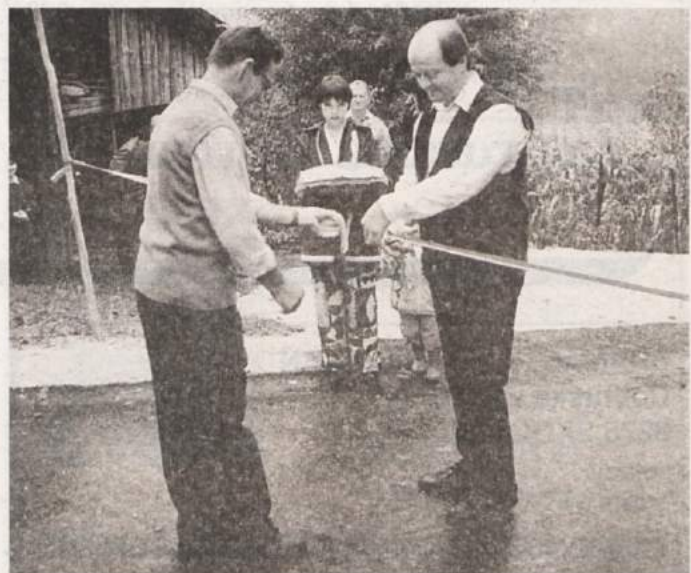
ASFALT NA ZAJČJO GORO - Za štiri domačije nad Ledganjem je bilo pravo veselje, ko je predsednika sevnške krajevne skupnosti Zvone Tuhtar prerezal trak (na posnetku) na cesti Ledganje-Zajčja gora, katera je dobila asfaltno podobo. Cesta je po strmini prava gorska, zato je bilo njeno vzdrževanje težko. Za te štiri domačije, kjer so doma predvsem upoko-jenci, je bil prispevek po nekaj več kot 300 tisočakov kar velik zalogaj, a danes ljudem ni žal. Preostali denar za asfaltiranje je prispevala KS Sevnica. (Foto: Jože Prah, ml.)
