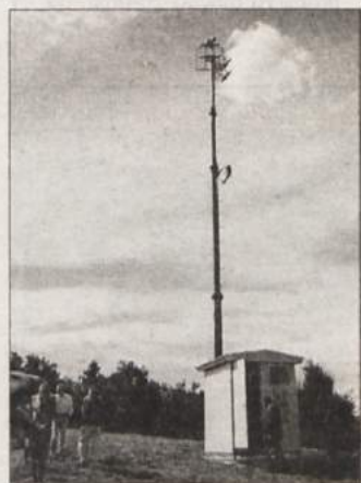
KONČNO SLOVENSKE PROGRAME - Pristojni so v sredo, 16. septembra, tehnično pregledali in prevzeli dva pretvornika, Sinji vrh 1 in Sinji vrh 2, na Sinjem vrhu, ki so ju za 12 milijonov tolarjev naredili v dveh letih. Pri graditvi je sodelovalo veliko krajanov, saj pretvornika zanje pomenita veliko pridobitev. Od zdaj naprej bodo namreč lahko spremljali tudi prvi in drugi program TV Slovenija, kar do zdaj ni bilo mogoče, pa še vedno ne vse vasi v tej KS. Ostanejo še Selce, Hrib ter najjužnejša vas Kot pri Damlju. Tu bodo skušali v najkrajšem možnem času napeljati satelitske sprejemnike. (Foto: L. M.)
