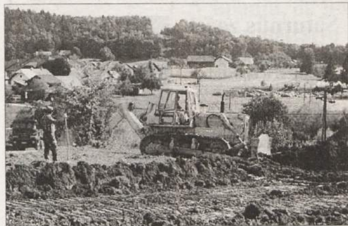
SEVERNA OBVOZNICA - Prejšnjo sredo se je začela gradnja težko pričakovane novomeške severne obvoznice. Na fotografiji je buldozer na delu nad železniško progo v Bučni vasi, od koder bo zgrajen viadukt do parkirišča pri Cestnem podjetju. Prvi odsek obvoznice od Muhaberja do Bučne vasi naj bi zgradili v enem letu. (Foto: J. Dornič)
