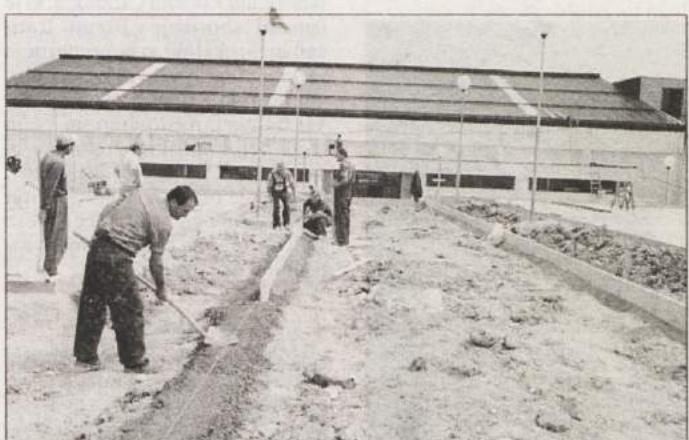
ŠPORTNA DVORANA - Ljubljanska SCT končuje dela pri gradnji nove športne dvorane v okviru Šolskega centra Novo mesto. Včeraj je bil tehnični prevzem gradbeno inštalacijskih del. Sedaj so v polnem teku priprave na proslavo 100-letnice Leona Štuklja, ki bo 12. novembra v tej dvorani, nato bodo montirali opremo za pouk športne vzgoje, temu pa bo sledil generalni tehnični prevzem. Računajo, da bo to ob koncu leta. (Foto: A. B.)
