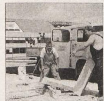
ZA VARNOST DIJAKOV - Delavci cestnega podjetja postavljata robnike za pločnik. V ozadju nova ekonomska šola.
