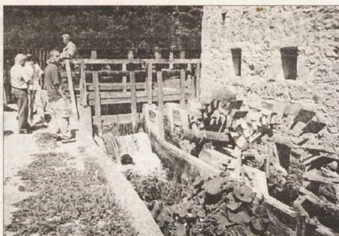
TRUBARJEVA DOMAČIJA POTREBNA OBNOVE - Zaradi dotrajanoosti so že skoraj popolnoma razpadla mlinska kolesa mlina na Trubarjevi domačiji.
