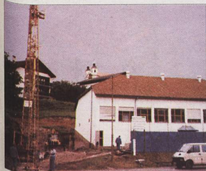
GRADNJA NOVEGA PRIZIDKA - Novi prostori bodo večnamenski, saj bodo v njem poleg športne vzgoje in ostalih športnih aktivnosti potekale tudi kulturne prireditve. (Foto: A. J.)
