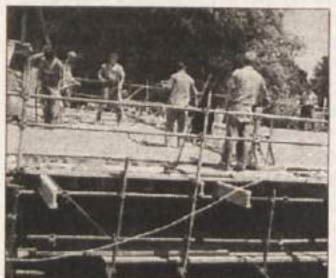
MOST NA PUŠČAVI - Konec prejšnjega tedna so delavci ljubljanskega Gradisa namestili opaž in armature, v ponedeljek pa so že z betonom zalili celotno ploščo (na posnetku). Takoj zatem so se lotili opaženja hodnikov oz. pločnikov, na obeh straneh mostu. Gradisovci so znova zatrjili, da hitreje takega mostu ne morejo zgraditi; zaradi tehnologije dela povsem zadošča okrog 12 delavcev in enozmenskemu delu. Zahvalili so se za dobro sodelovanje novomeškega vodjarjem, sevniškimi ribičem, Elektru in Telekomu. (Foto: P. P.)
