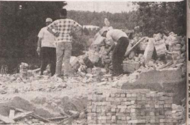
NA RUŠEVINAH NASTAJA NOVO - V novomeškem Bršljinu, ki je bil prej postaja trgovski center dolenjske metropole, je sredi maja začelo nastajati nekaj starih zgradb. Gradbeni delavci in stroji so jih "pospravili", bi naredili mesto novemu. Tokrat bo v razvoj trgovskega centra na Dolenjskem vlagal Spar, ki očitno ocenjuje, da ima nekaj prednosti pred številnimi konkurenčnimi centri. (Foto: B. D. G.)
