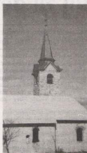
Obnovljen zvonik na cerkvi sv. Mihaela
