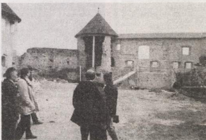
ZAČETEK - Lani obnovljena in utrjena južna stena.
