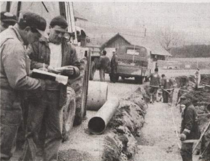
GRADBIŠČE V VRANOVIČIH - Zadnji mesec so Vranoviči veliko gradbišče. Cestno podjetje Novo mesto in Komunala Črnomelj namreč ob regionalni cesti, ki vodi skozi vas, v dolžini 700 metrov urejata cestno kanalizacijo in javno razsvetlavo, rekonstruirata vodovod, na koncu pa bosta uredila še pločnik. (Foto: M. B.-J.)
