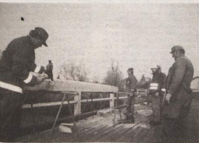
MOST NA KRKI V CERKLJAH OB KRKI - Ker je bil leseni cerkljanski most pred časom ob nekaj metrov varovalne ograje in ker je njegova lesena vodna površina spet začela dobivati jame, so ga pred dnevi vzeli v roke delavci Cestnega podjetja Novo mesto iz Sektorja Brežice. Pri tem posegu so uporabili okrog 3 kubične metre hrastovega lesa. Leseni mostovi, ki jih je vzdolž Krke v Posavju še nekaj, vse težje prenašajo vedno gostejši promet motornih vozil, zato jih morajo pogosto vzdrževati. Most v Borštu se je celo vidno pogreznil, zato se delavcem cestnega podjetja (verjetno njim!) obeta dosti obsežnejše popravilo, kot je bilo omenjeno in ki ga kaže fotografija. (Foto: L. M.)
