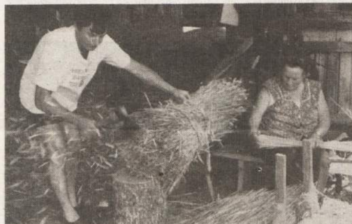
ŠKOPNIK - Predno gre na streho, je treba škopnike ržene slame lepo obsekati in zložiti. To delo sta opravila gospodar Jože in njegova tašča Milka Šoš. Že prej pa so se na dveh ročnih žetvah s slamo trudile domače žanji- ce. Za tako streho je potrebno 330 škopnikov.
