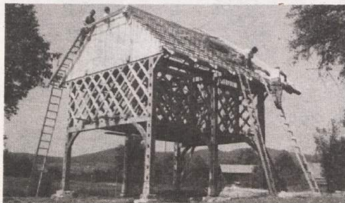
KOZOLEC - Škofovo domačijo na Črešnjevcu diči nov leseni leptec, ki sta ga v štirinajstih dneh postavila tesarja Miro Kambič iz Črešnjevca in Miro Kralj z Osojnika. Nosilni stebri so hrastovi, prav tako ogrodje, ostrežje in oboj pa je iz smrekovega lesa.
