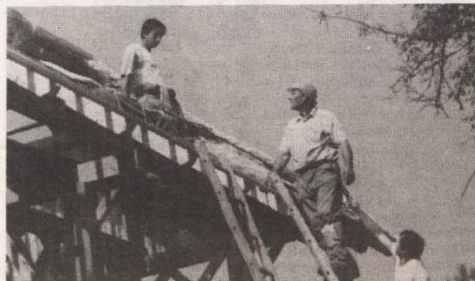
KROVCI - Slamnato pokrivalo je kozolcu naredil mojster Jože Vranešič iz Črnomlja, eden redkih na tem koncu, ki je še več tega posla. Tudi Jože Firm, profesor z grške kmetijske šole, mu je z nekaj učenci priskočil na pomoč in se pri tem marsikaj naučil.
