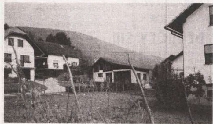
KAJ JE SPORNO - V Podhosti je med Pečaverjevimi in Mihaličevimi prišlo do spora zaradi greznice, ki naj bi zamakala na sosedovo, zaradi sporne škarpe, ki naj bi bila preblizu meje, in zaradi hleva z garažo, ki je menda prav tako preblizu meje. (Foto: T. G.)
