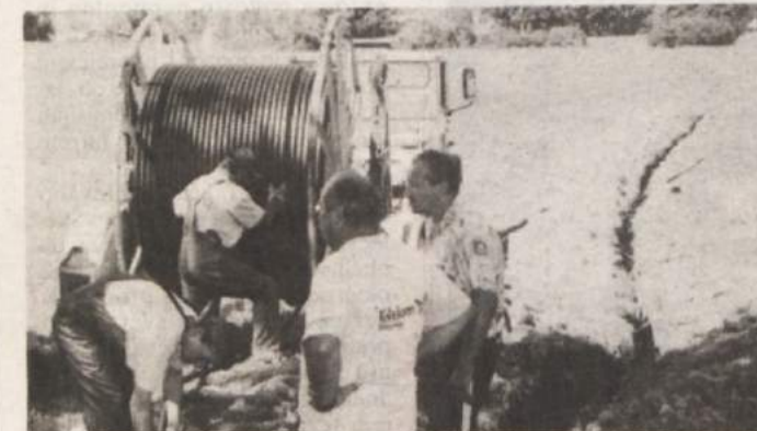
OPTIČNI KABEL MED RIBNICO IN SODRAŽICO - Pred kratkim je Telekom začel polagati deseterakmetrski optični kabel med Ribnico in Zlebičem s 36 vlakni, od Zlebiča do Sodražice pa bodo položili kabel z 12 vlakni. Preko tega bodo povezali tudi Loški Potok in kasneje Drago. V Loškem Potoku in Sodražici delujejo digitalne centrale preko koaksialnega kabla, zmogljivost teh zvez je na meji dovoljenih prometnih izgub. Optični kabel je velika pridobitev, saj po dveh vlaknih lahko spustijo 10.000 pogovorov, ne da bi morali med potjo signal ojačevati. (Foto: M. Glavonjić)
