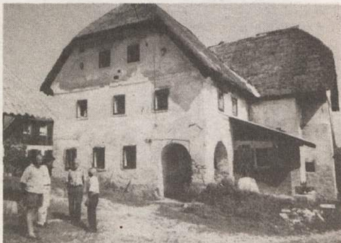
PRISTAVA ORTNEŠKEGA GRADU - Brez prizidane kopalnice bi bila stavba domala takšna, kot pred stoletji.
