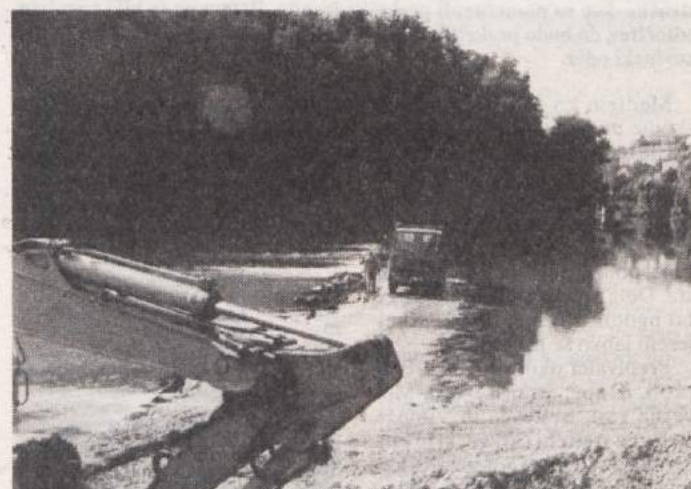
OBNOVA JEZU NA ŽAGI - Pred dnevi je novomeško Vodnogospodarsko podjetje začelo obnavljati novomeški jez "na žagi", ki je bil že precej načet in "skrbast". Jez bodo obnovili in zatesnili in tako se bo gladina Krke nad njim dvignila za okoli 30 cm. Dela bodo stala 25 milijonov tolarjev, denar je zagotovilo ministrstvo za okolje in prostor, dela pa naj bi bila končana do začetka septembra. Energetska izraba jez "na žagi" ni predvidena. (Foto: A. B.)
