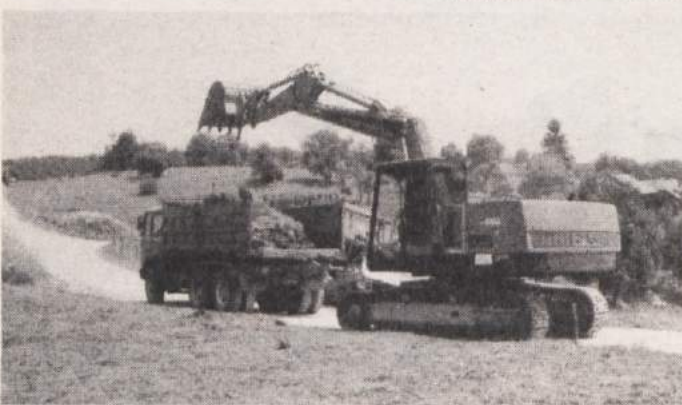
KONČNO MODERNIZACIJA - V začetku preteklega tedna so pričeli z razširitvijo skoraj 3 km dolge ceste od Goliša do Gradnika. Končana naj bi bila do konca avgusta, s tem pa bodo dobile asfaltno povezavo štiri vasi, in sicer Omota, Gradnik, Sodji Vrh in Praproče. Če bo občini uspelo dobiti še 10 milijonov tolarjev, pa bodo asfaltirali tudi cesto od Goliša do Štrekljčeva. (Foto: M. B.-J.)
