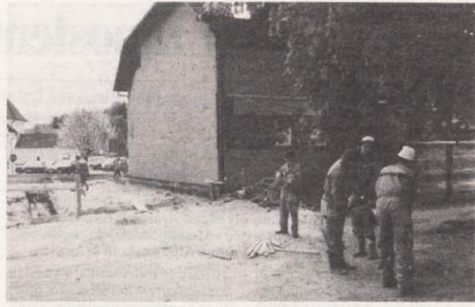
GRADNJA LEKARNE - V Škočjanu so delavci Strešnika iz Dobruške vasi prejšnji teden začeli z gradnjo prizidka k zdravstvenemu domu, kjer bo prostor že čez dva meseca dobila lekarna, pa tudi njihova knjižnica. S tem se bo Škočjancem uresničila dolgoletna želja po lekarni v svojem kraju. (Foto: J. Dornič)
