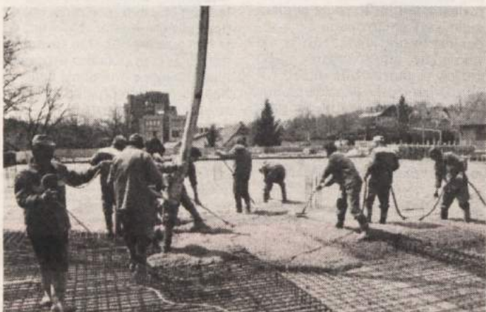
350 KUBIKOV BETONA - Celih 10 ur je prejšnji četrtek trajalo betoniranje plošče na Krkini parkirni hiši v Ločni. Kamioni mešalci novomeškega Cestnega podjetja so v 78 voznjah pripeljali kar 350 kubikov betona iz njihovih betonarn v Gotni vasi in z bršljinske Livade. Plošča meri 2.200 m2 in to je bilo eno največjih strojnih vgrajevanj betona, vodil pa ga je vodja betonarn Cestnega podjetja Martin Blažič. Krkino parkirno hišo, v kateri bo v treh etažah 240 parkirnih mest, gradi Pionir Standard, avtomobili pa bodo dobili streho do 20. maja. (Foto: A. B.)
