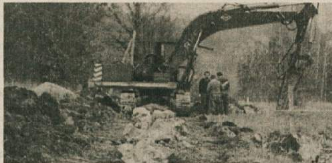
KONČNO VODOVOD - Sredi novembra so pričeli v Nestopli vasi kopati za vodovod proti Brezju in Pugledu, zaselkoma z osmimi gospodinjstvi. Gre za projekt gradnje vodovoda iz leta 1983, ko so zaradi odkritja PCB v Krupi morali spremeniti projekte, po katerih so predvideli vodovod iz izvira te reke in povezavo vasi z zajetjem v Doblčah. S tokratno gradnjo vodovoda bodo omenjeni projekt zaključili, s tem pa bodo imele vodovod vse vasi v južnem delu semiške občine. (Foto: M. B.-J.)
