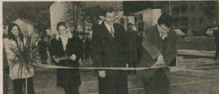
BENCINSKI SERVIS - Bencinski servis Omv-Istra na Senovem, ki je veljal poldrugi milijon mark, so zgradili v skladu z najstrožjimi zahtevami, ki veljajo v svetu za take objekte. Na črpalke, ki bo odprta od 6. do 22. ure, bodo naprodaj štiri vrste nafnih derivatov. Na tem bencinskem servisu bodo še vulkanizerska in avtomehanična delavnica, ročna avtopralnica, mala samostrežna trgovina z mešanim blagom in bife. Prodajali bodo tudi gospodinjski plin. (Foto: L. M.)
