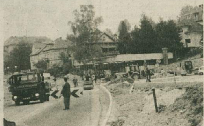
DO KDAJ BO SEIDLOVA ŠE GRADBIŠČE? - Konec preteklega tedna so delavci pripravljali vozišče za polaganje asfalta in v začetku tega tedna začeli z asfaltiranjem. Po Lebanovih besedah bodo konec tega tedna zaprti za ves promet in položili še zaključni asfaltni beton. Potem bodo še naprej urejali pločnike in škarpe ob cesti. Vsekakor mora biti cesta popolnoma prevozna do konca oktobra, vodja gradbišča pa si v teh dneh še ne upa napovedati, kdaj bo gradbišče zaprto in vsa dela končana. (Foto: B. D. G.)
