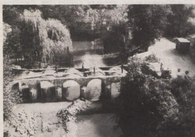
OBNOVITEV MOSTU — Most čez Dobljico na Loku so delavci celjskega Ingrada že začeli obnavljati, z bližnjim mostom čez Lahinjo pa bodo morali na zahtevo krajanov počakati, dokler ne bodo zgradili pomožnega za obvoz do mestnega središča. (Foto: T. J.)
