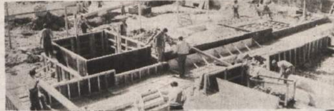
GRADNJA V TOPLICAH — Spomladi so začeli s pripravami na gradnjo zdravstvenega prizidka v Dolenjskih Toplicah, do prihodnje turistične sezone pa mora biti nared. S tem prizidkom bo zdraviliški kompleks zaokrožen in zagotovljen bo bistveno višji medicinski standard. (Foto: A. B.)
