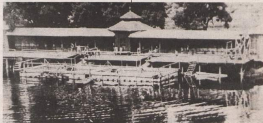
Kopaljšče na Loki pod sedanjim novim mostom v Novem mestu, fotografirano v začetku tega stoletja. Se bo našel kdo in kaj podobnega zgradil?
