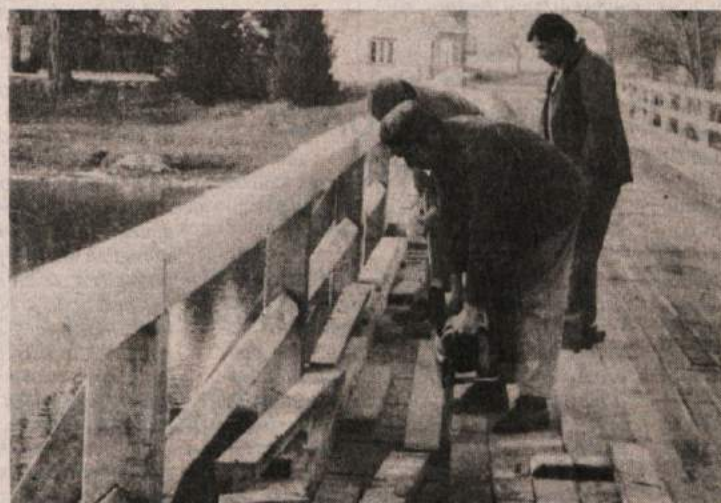
MOSTOVI SPET TRDNEJŠI — Delavci Cestnega podjetja iz Brežic opravljajo še zadnja dela na popolnoma prenovljenem lesenem mostu čez Krko pri Podbočju. Od tukaj se bodo preselili na oba mosta v Kostanjevici, ki že dolgo ključeta po prenovi. (Foto: T. Jakše)
