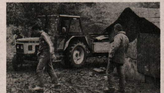
BARAK NI VEČ, KJE SO ROMI? - Dva dni je trajalo rušenje na črno postavljenih barak v romskem naselju Šmihel pri Novem mestu (na posnetku), od kakih 50 ali 60 Romov, ki so ostali brez strehe nad glavo, se jih je na novo lokacijo v Žabjeku do minulega petka preselilo vsega osemnajst. (Foto: B. B.)
