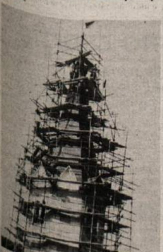
CERKEV NA LOGU V NOVI PREOBLEKI — Krajani Loga nadvse zavzeto obnavljajo podružnično cerkev sredi vasi. Zamenjali so celotno ostrežje fresko iz 16. stoletja. Prejšnji teden so delno obnovili tudi ostrežje stolpa. Ta teden bodo kleparski mojstri oblikovali stolp v bakreni pločevino, fasado cerkve pa bodo obnovili sevnški gradbinci. Dela vodi in usklajuje poštanjski župnik Srečko Golob. (Foto: P. P.)
