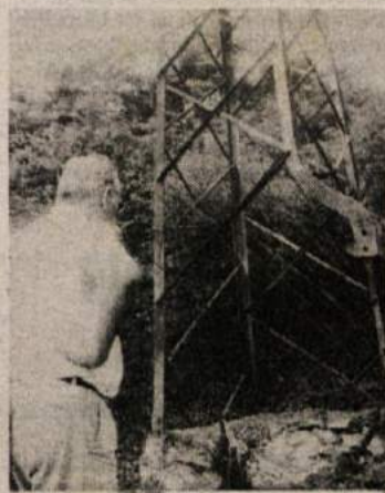
MINIRAN DALJNOVOD — Neznani teroristi so v noči s 1. na 2. avgust minirali tri daljnovode v bližini Krškega. Eksploziji sta poškodovali stebra na 20 in 110-kilovoltnem daljnovodu, medtem ko so na enem od stebrov 110-kilovoltnega daljnovoda strokovnjaki eksploziv odstranili. Razdejanje, ki ga je eksplozija povzročila na stebri daljnovoda pri znanem krškem gostišču Tri lučke, so si ogledali tudi predsednik slovenske vlade Lojze Peterle in njegov gost, koroški deželni glavar dr. Christoph Zernatto s sodelavci. Teroristični diverzanti so uporabili plastično razstrelivo, opremljeno s svetlobno celico, strokovnjaki pa pravijo, da tako razstrelivo izdelujejo samo v beograjskem Institutu za bezbednost. (Foto: A. B.)
