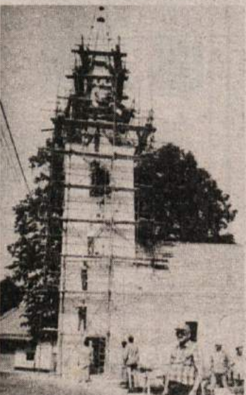
PREOBLEKA SV. ROKA — Podružnični cerkvi v Šalki vasi so vaščani dali lepšo podobo. V sedem letih so v množični delovni akciji odstranili zvonika še gradbeni oder, da je nova bakrena kupola zablestela v vsem sijaju. (Foto: T. Jakše)
