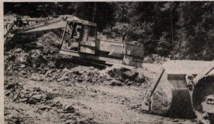
RAZŠIRITEV ODLAGALIŠČA ODPADKOV — Sedanjo črnomaljsko deponijo komunalnih odpadkov so le pričeli razširjati, čeprav so se prebivalci bližnjih vasi Vranoviči in Zavista temu dolgo časa upirali. Zemeljska dela opravljata Grad po Smeltovem projektu, največja pozornost pa je namenjena utrjevanju tal, ki jih bodo trikrat valjali ter s tem dosegli nepropustnost. Ali bo delo zares strokovno opravljeno, bo na koncu ugotovil Geološki zavod. Sicer pa naj bi bila dela končana do 26. avgusta. Komunalna pa bo potem takoj začela tja dovažati odpadke, saj je sedanje odlagališče že prepolno. (Foto: M. B.-J.)
