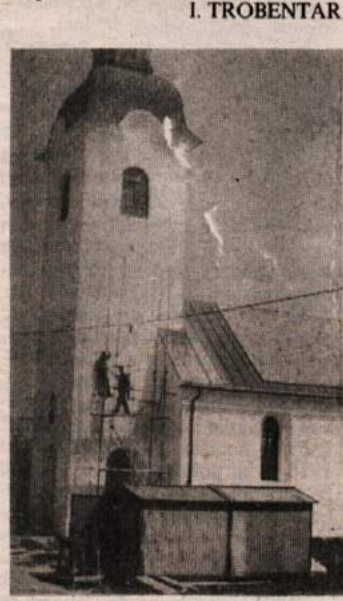
CERKVE OBNAVLJAJO — Delavci SGP iz Grosupljeva v teh dneh končujejo dela pri zaščiti in popravilu vaše cerkve v Maršičih pri Orneku v ribniški občini. V ribniški dolini je še veliko cerkva potrebnih obnove in zaščite, vendar primanjkuje denarja. (Foto: M. Glavonjič)
