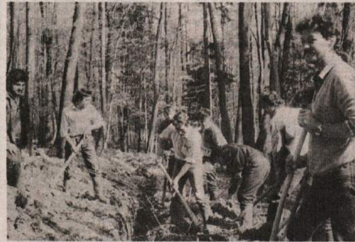
VODOVOD — Pred dnevi so zasipavali zadnje metre jarka, v katerega so položili cevi za nadomestni vodovod in Mrtovcu. Gradnjo tega vodovoda so organizirali kot javna dela v KS Boštanj in s tem zaposlili 10 mlajših brezposelnih ljudi. Podlrgni kilometer dolgi vodovod, katerega vrednost z uradnim predračunom cenijo na 450 tisoč din, sta v pretežni meri plačala Petrol in IMP Inženiring. Na fotografiji: najeti delavci zasipavajo jarek. (Foto: M. Luzar)
