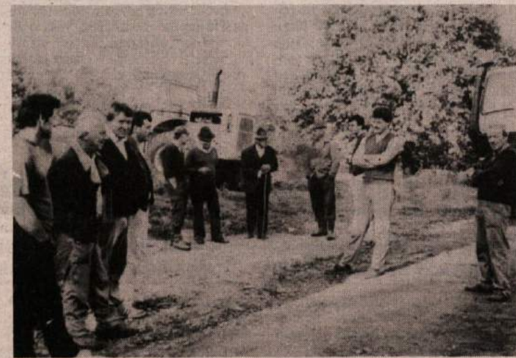
PREPREČILI IZKOP — Vranovičani in Zastavljeni so se takole postavili pred gradbene stroje na odlagališču komunalnih odpadkov pri Vranovičih in preprečili, da bi stroji pripravljali teren za razširitev deponije. Kako zares so vzeli odločitev, da novega odlagališča v bližini njihovih vasi ne bo, pove tudi to, da so bili pripravljene stati pred stroji toliko časa, dokler strojev ne bi odstranili. (Foto: M. Bezek-Jakše)
