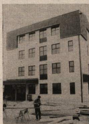
ZASEBNI MLIN — Ta velika zgrad- ba dokaj nenavadne oblike je nekaj časa privlačila poglede mimoido- čih. Če bo vse po sreči, bodo že aprila v njej zmleli prve tone pšenice. (Foto: J. S.)
