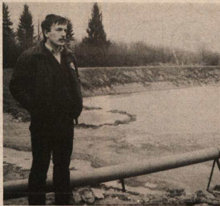
Vodja farme Ivan Trdan ob laguni, kjer je zaradi poglobitve prišlo do udara in izteka gnojevke v podzemlje. Zamašeni udor je na posnetku še dobro viden desno od Trdana.
