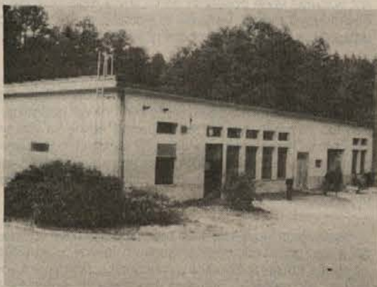
Črpališče Jezero pri Družinski vasi je moderno urejeno. Novomeški občini lahko dobavi največje količine pitne vode, kar 235 litrov na sekundo. Voda ima 17 stopinj celzija in je fizikalno kemično neoporečna.
