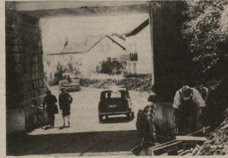
POGLOBLJEN PODVOZ — Prenizek cestni podvoz med Metliko in Rosalnicami je bil huda ovira, saj se je marsikateri večji tovornjak, namenjen v bližnji Komet ali Novolesov tozd, zagodil v njem in tako zaprl pot ostalim vozilom. Sedaj so ta podvoz končno poglobili in ne bo več oviral prometa. (Foto: A. Bartelj)
