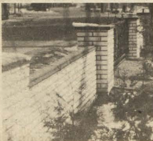
Ograja iz fasadnega zidak.
