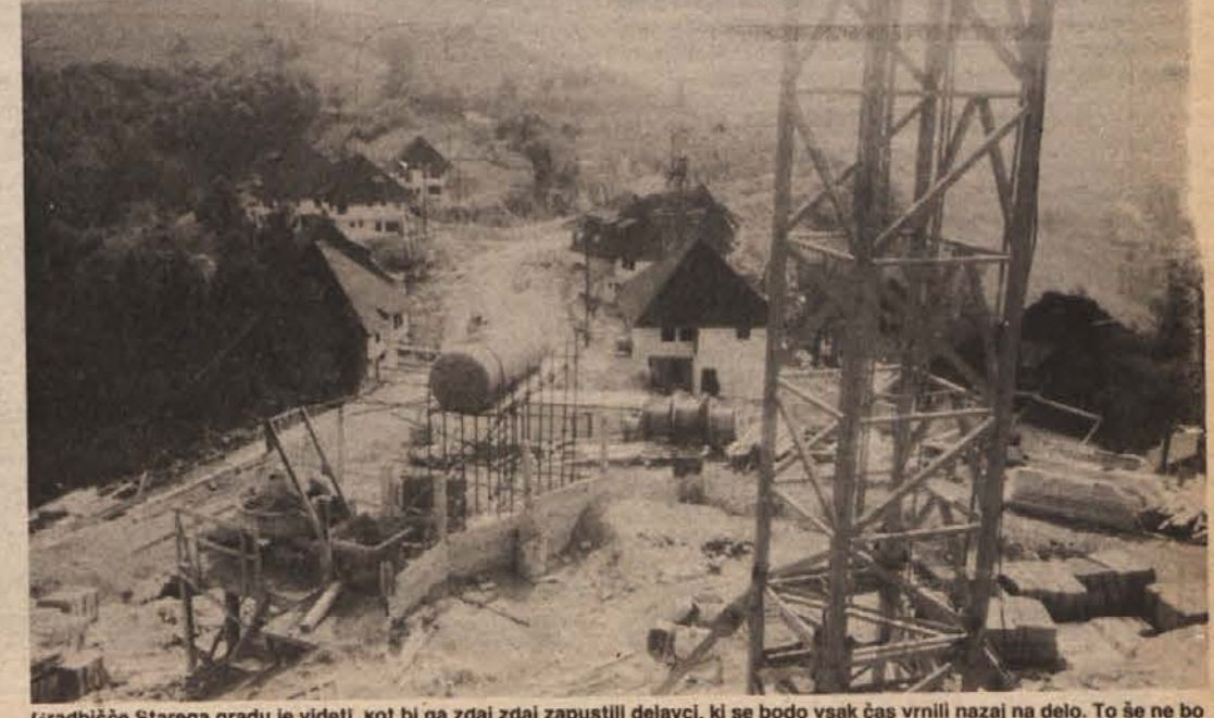
Gradbišče Starega grada je videti, kot bi ga zdaj zdaj zapustili delavci, ki se bodo vsak čas vrnili nazaj na delo. To še ne bo kmalu. Nekateri se celo boje, da bo 16 paviljonov z gradom postalo spomenik nekemu času.
