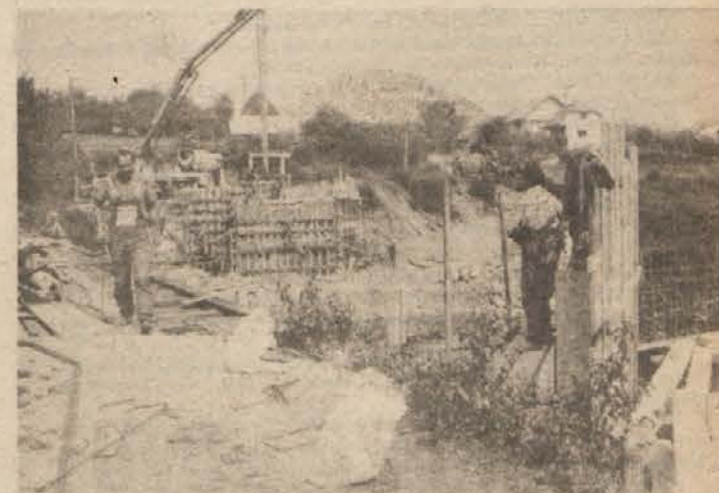
MOST ČEZ LAHINJO — Dela pri gradnji mostu čez Lahinjo pri Gersičih lepo napredujejo. Čeprav so zaradi nepredvidenih dodatnih del pri temeljenju nekaj dni v zaostanku, delavci Slovenijacest-Tehnika računajo, da bo most zgrajen do roka, se pravi do srede decembra. Če pa jim vreme ne bo preveč nagajalo — do sedaj je kot nalašč za tako gradnjo — pa bi ga lahko že za dan republike slovesno predali namenu. (Foto: A. B.)
