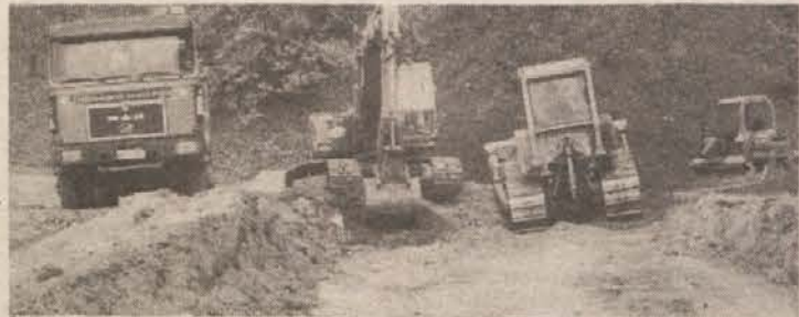
ASFALTIRAJO CESTO NA LISCO — Delavci novomeškega Cestnega podjetja so že pričeli z deli za asfaltiranje ceste na Lisco, kjer bo prihodnje leto praznovati ob 50. obletnici seje politburoja CK KPJ. Rok za dokončanje del — zemeljskih, gradnjo propustov in asfaltiranje — je sicer 1. maj prihodnje leto, vendar računajo, da bodo vsa dela opravili še pred letošnjo zimjo. Dela bodo veljala milijardo dinarjev, sredstva pa je prispevala republiška cestna skupnost. (Foto: J. Simičič)
