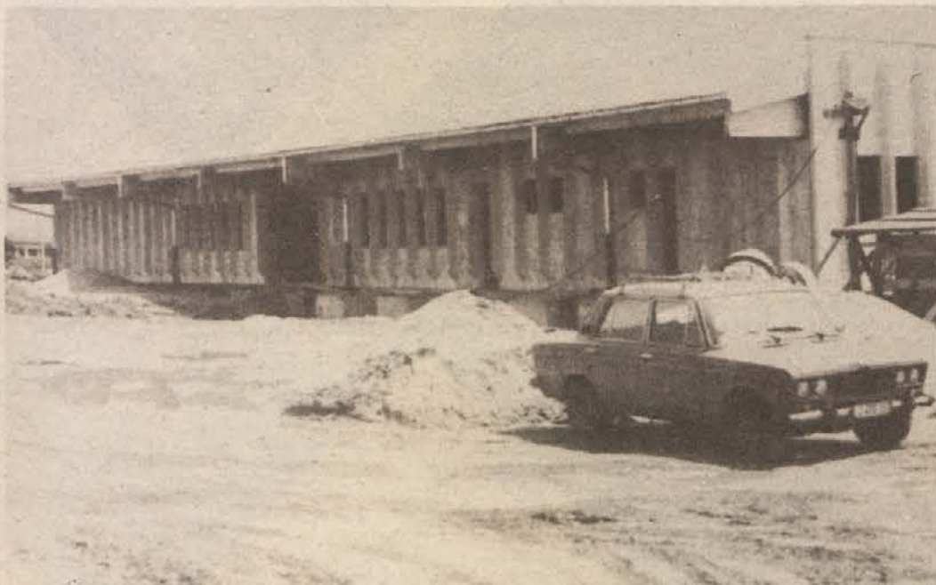
Skladišče kmetijskih pridelkov v izgradnji.
