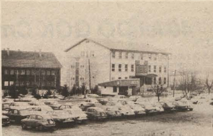
Beltova nova poslovna stavba
