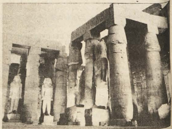
Tempelj v Luksorju se spreminja v stebre in zidove brez reliefov. Vlaga in sol uničujeta ta pomembni spomenik in mnoge druge.
